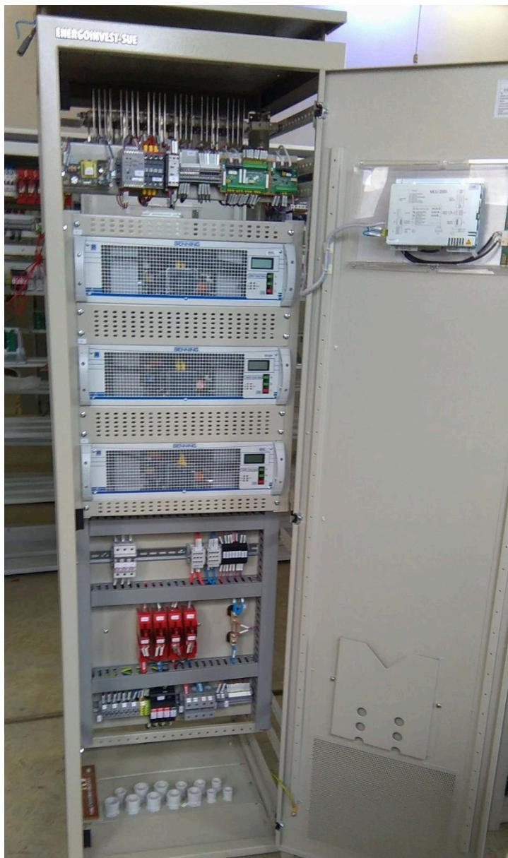
Telecom sistemi sa 48VDC su najčešća sa EATONovim modulima, dok su sistemi sa 110VDC i 220VDC sa BENNINGovim modulima.
