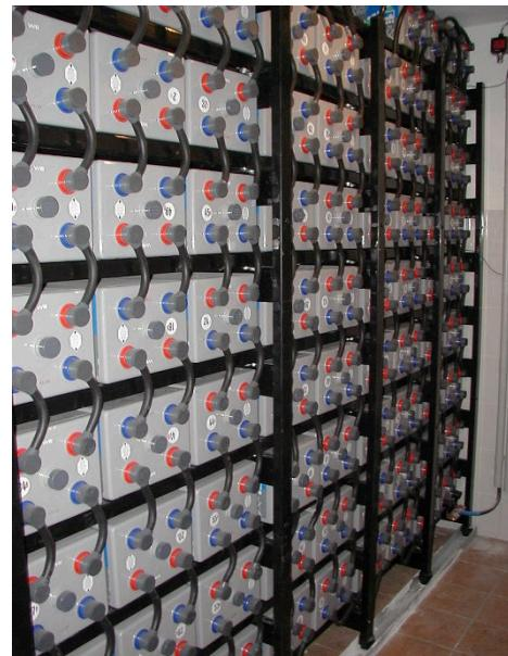
Uz ove ispravljačke sistem isporučujemo i baterije, koje se najčešće montiraju u donjem dijelu ormara kod manjih sistema ili u odvojen ormare ili na baterijske stalaže kod većih sistema.
